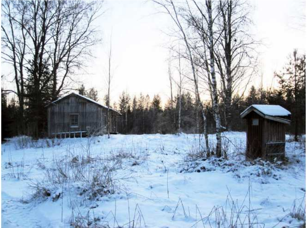
Kuva 17 Kalliomaan rakennuspaikka (kuva: Risto Suikkari, Ylivieskan kaupunki)
