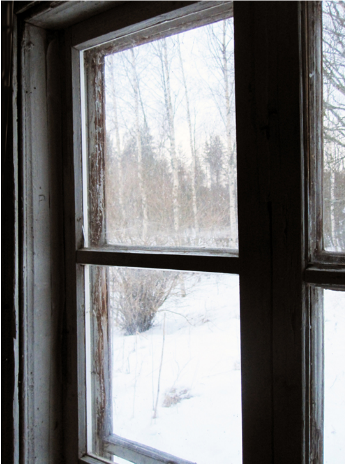
Kuva 13. Ikkunadetalji tuvassa säilyneistä vanhoista sirorakenteista ikkunoista.
