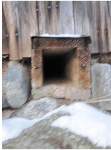
Kuva 9. Kivistä ladottua perustusta sekä puurakenteinen kanava tuvan lattian alle.
