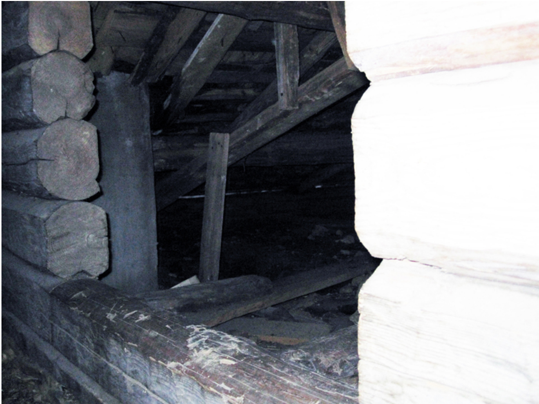
Kuva 8. Näkymä porstuan ullakolta tuvan ullakolle. Tuvan savupiipun vierellä näkyy tuvan sisäkaton ylhäältäpäin kapuloitu kannatus. Piipun ympärillä on kattorakenteissa mustumia, mutta muuten ullakkorakenteet näyttävät kuivilta ja hyväkuntoisilta.
