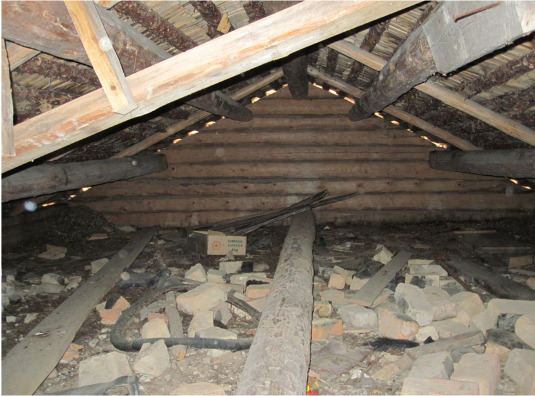
Kuva 7. Tuvan ullakon kattorakennetta.
