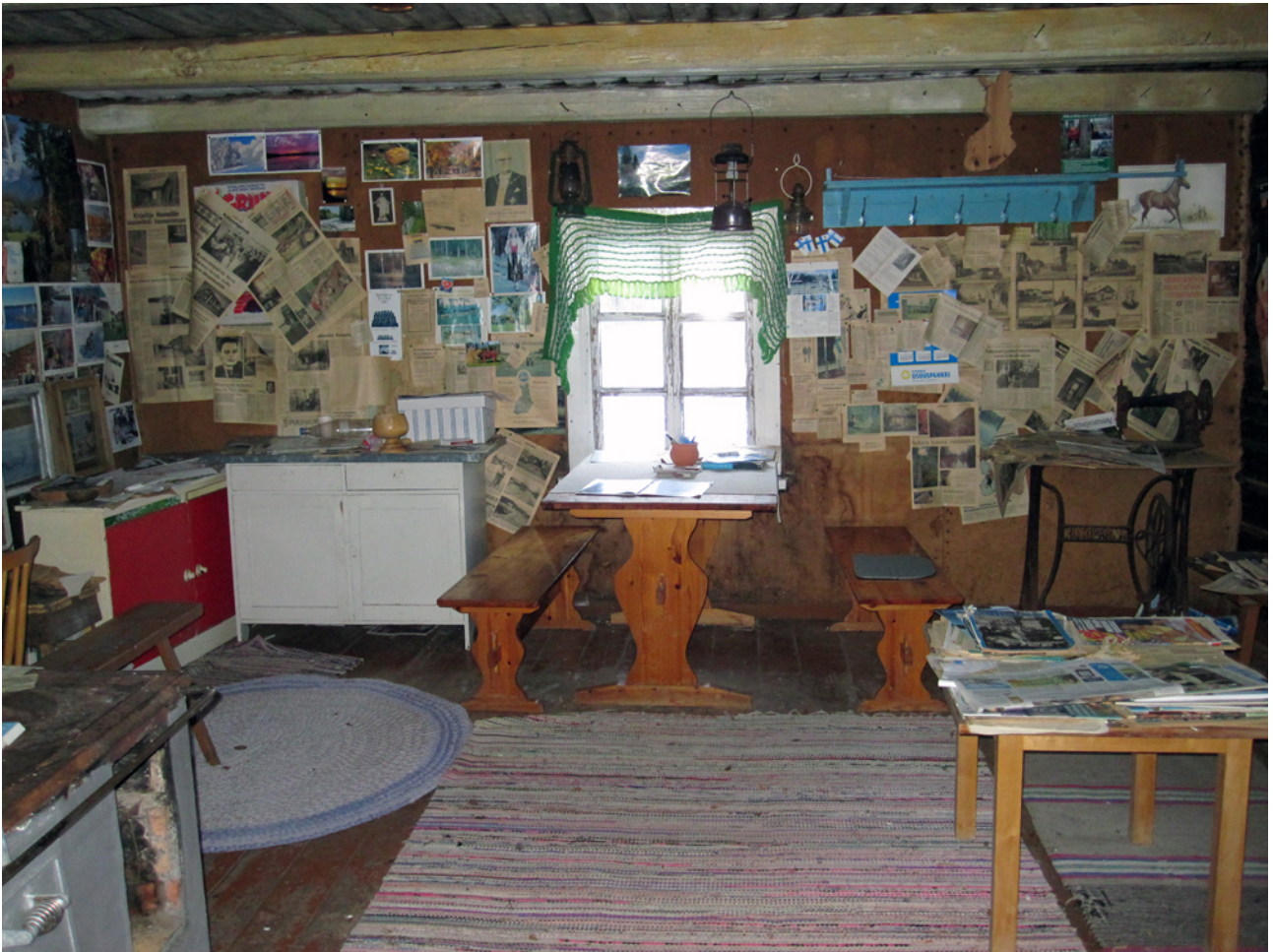
Kuva 14. Näkymä tuvasta. Sisäseinät on kauttaaltaan verhottu kuitulevyllä. Kattoa kannattavat veistetyt hirret.
