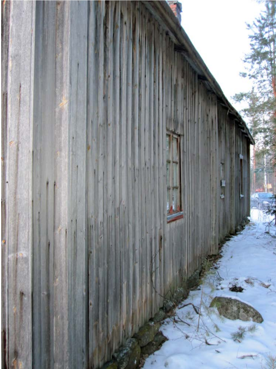
Kuva 12. Rakennuksen takajulkisivu kaakkoon.
