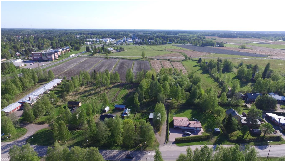
Kuva 3. Suunnittelualueen itäosa pohjoisesta päin kuvattuna v. 2018
