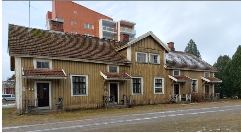
Rautatiekatu 12 A peruskorjattu 1982 (Antti Pihkala 1998)
