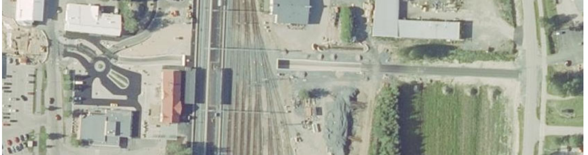
Kuva: Rautatieaseman edustan liikennejärjestelyt ja kevyen liikenteen väylä keskustasta Ratakadulle Koskipuhtoon valmistuivat 2019.
