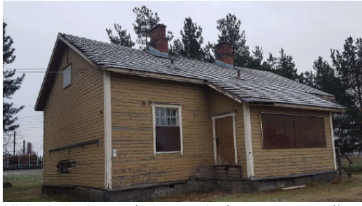
Kirjanpitäjä- vahtitupa /rakennus on ollut kylmillään
