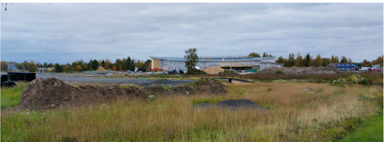
Kuva: Taanilan yhtenäiskoulu rakenteilla /syyskuu 2020
