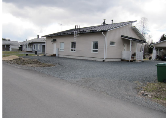
Koskelotie 1, kt 977-9-89-18, on rakennettu 2011-2012
