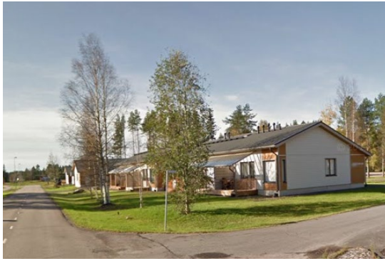
9-95-2, rivitalot ovat rakentuneet vuosina 2009-2011 Asunto Oy Ylivieskan Käenpiika Kanatie 2, Asunto Oy Ylivieskan Käenpoika Lintutie 49
