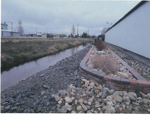
Kuva 6. Maler Oy on tontillaan kivennyt Salmelanojan penkan sekä rakentanut pientareelle paikan istutettaville pensaille.
