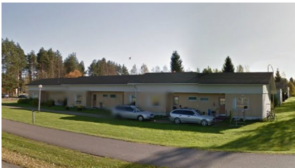
Lintutie 16, kt 977-9-74-1 tontilla 4 rivitaloa, rakennettu vuonna 1969
