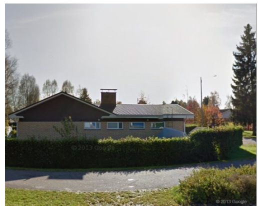
Tavitie 2, 977-9-76-1, rakennettu v. 1973
