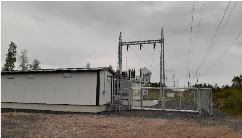
Kuva 11. Kiinteistö 977-406-0005-0315, v. 2019, muuntoasema.
