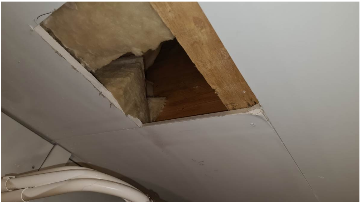
Välipohjaan tehtiin aukaisu, mistä rakenne tarkastettiin.
