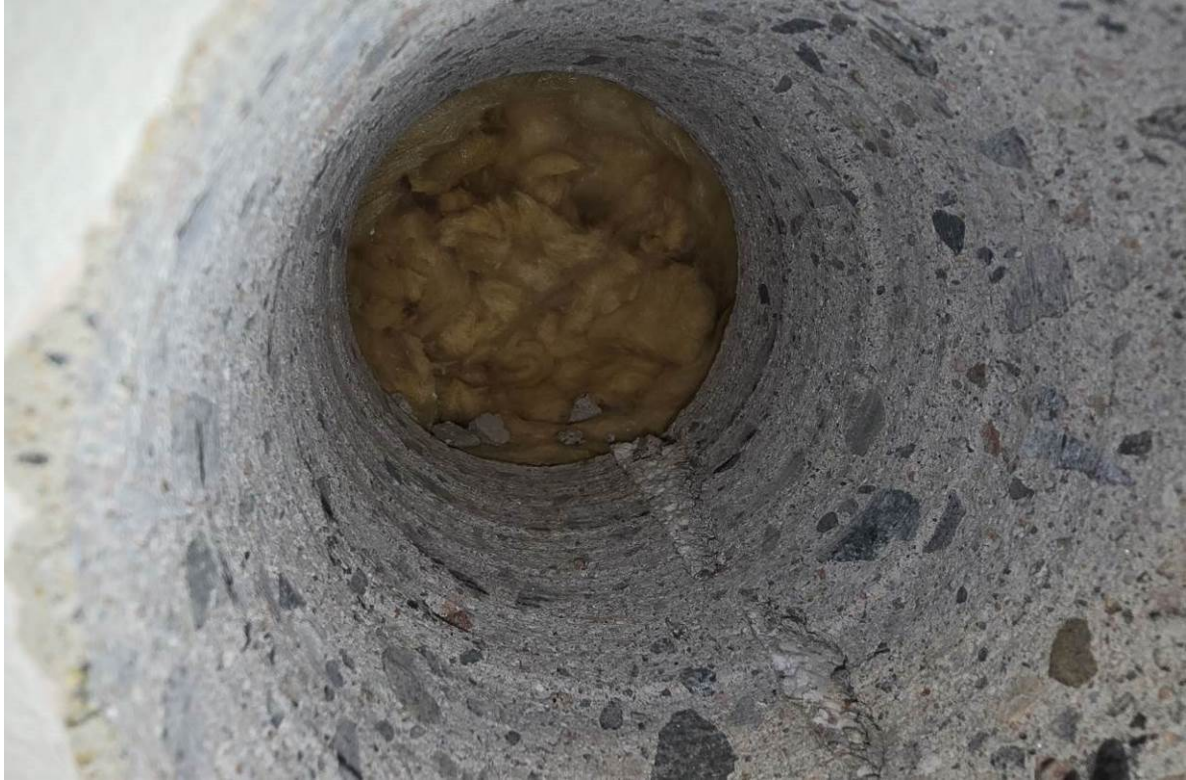
Kuva avauskohdasta väliseinässä
