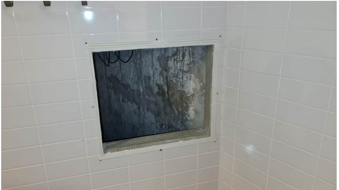
Luukku tyttöjen pukuhuoneesta koteloon
