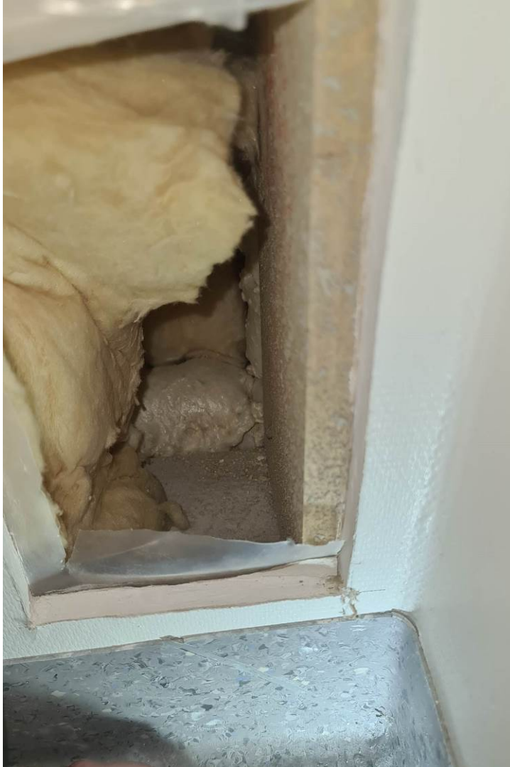
Seinän aukaisu kohta. Uretaania alajuoksun sivulla
