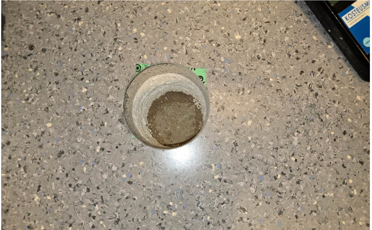
Rakenne avaus tehtynä pohjavaluun asti.
