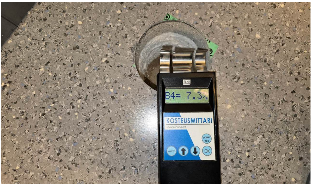
Pohjavalun kosteus kohollaan pintakosteusmittarilla
