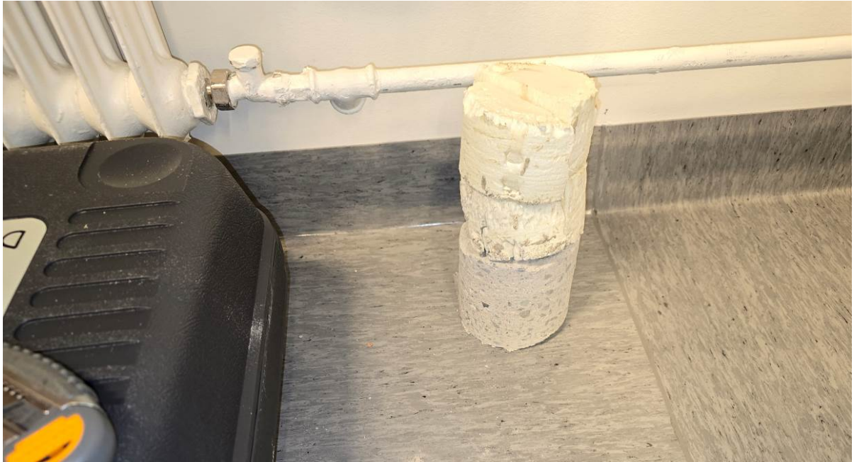
Lattian rakenne kerrokset, eristeenä uretaanilevy
