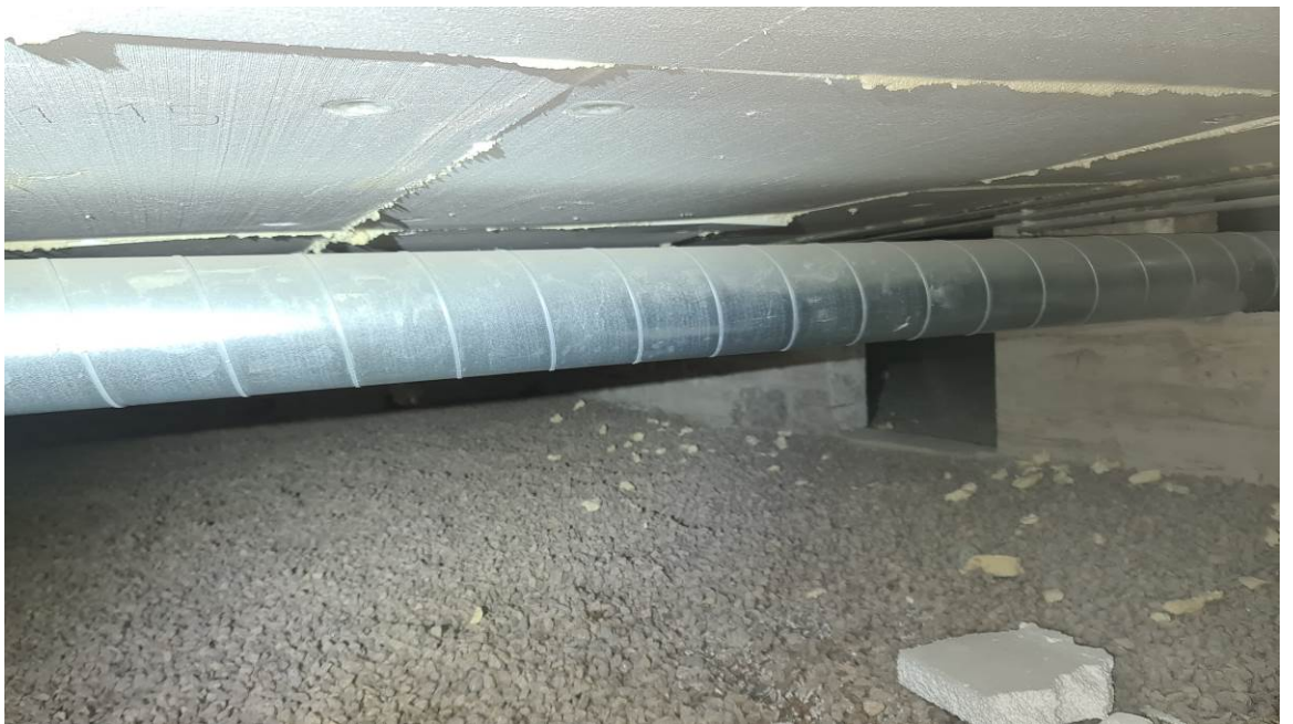
Tyttöjen pukuhuoneen alustan ryömintätila
