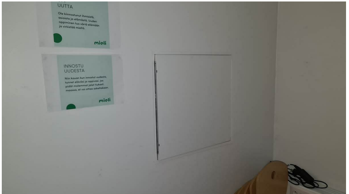
Putkikotelon luukku aulaan
