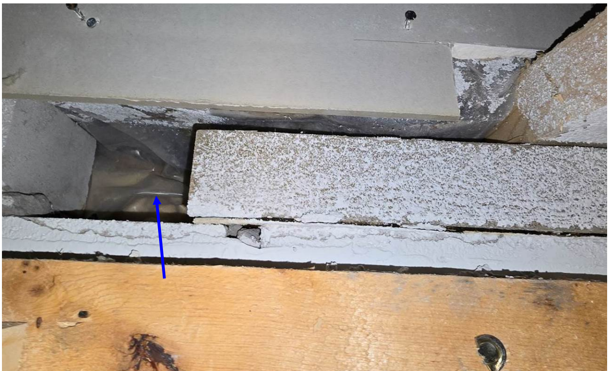
Höyrysulku menee tiilen taakse, Em. kohdalta otettiin ulkoseinä villasta materiaalinäyte M5
