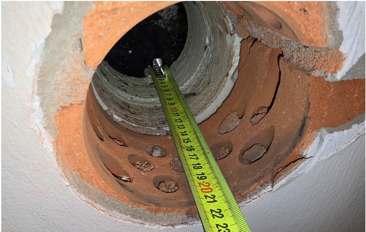
Seinän rakenne avaus
