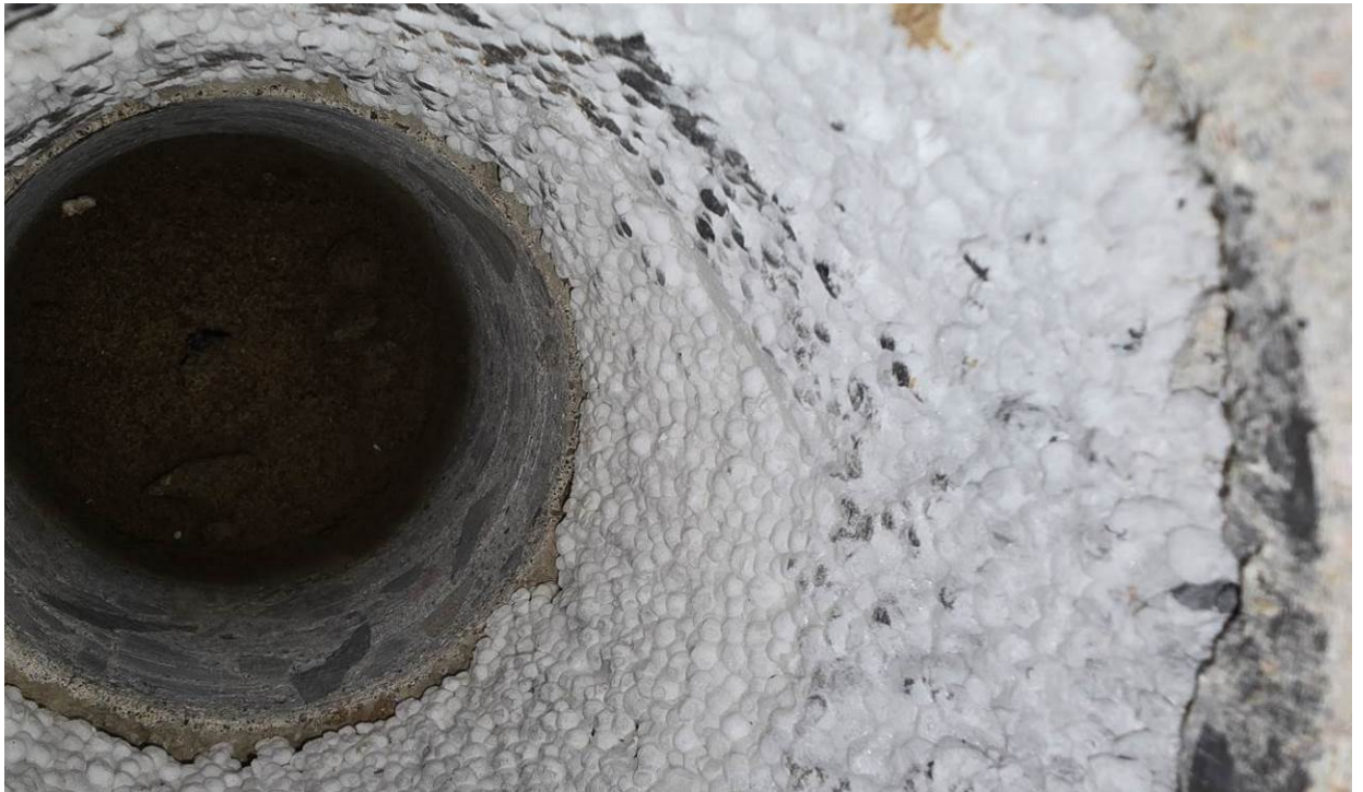
Avaustehtynä pohjavalun lävitse, Alla hiekka kosteaa.
