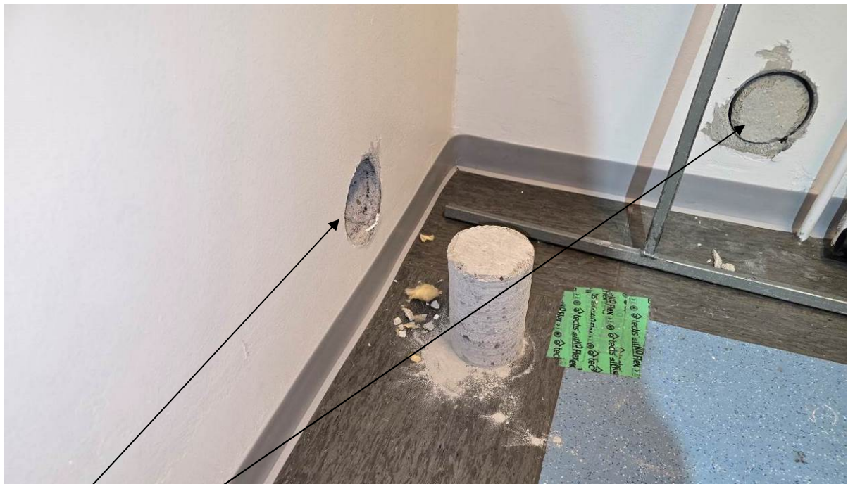
Väliseinän ja ulkoseinän avauskohdat
