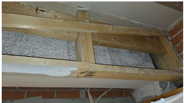
Vessojen edustalla käytävän puolella puurakenteisen välipohjan tiivistys, ettei villoja näkyvillä.
