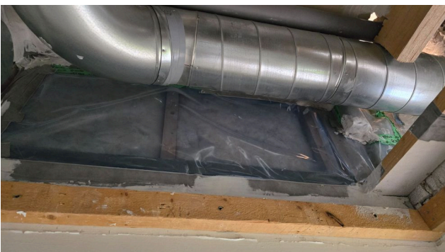
Alakerran wc ulkoseinä höyrösulku tiivistetty Seinän yläosassa
