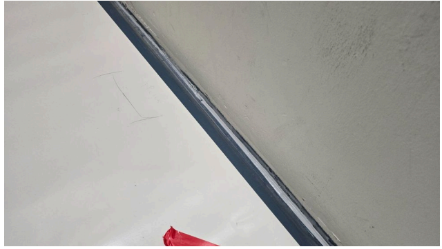
Liikuntasali seinän ja lattian liitos tiivistetty
