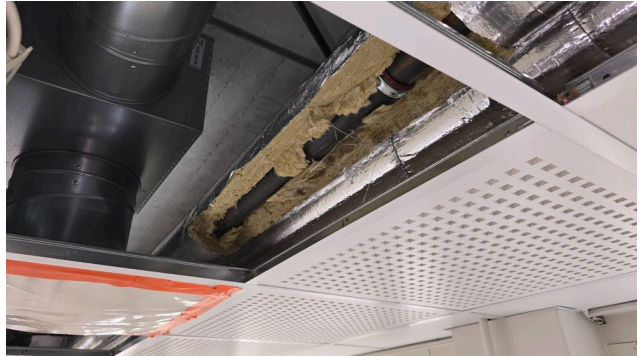
Alakerran käytävä katossa putkieristeet villa näkyvillä
