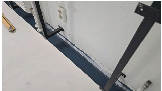
Liikuntasali seinän ja lattian liitos tiivistetty
