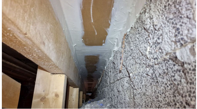
Vessojen edustalla käytävän puolella puurakenteisen välipohjan tiivistys, ettei villoja näkyvillä.
