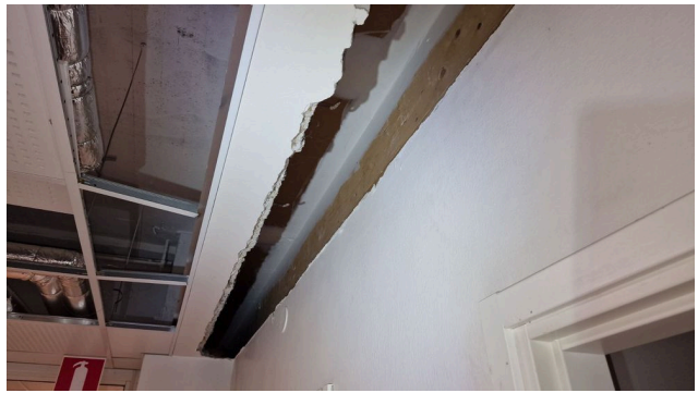
Käytävän puolelta. vanhat ulkoseinä harkot poistettu
