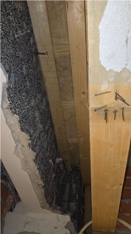
Inva wc kattoon laudat ja levy,villat koteloidaan
