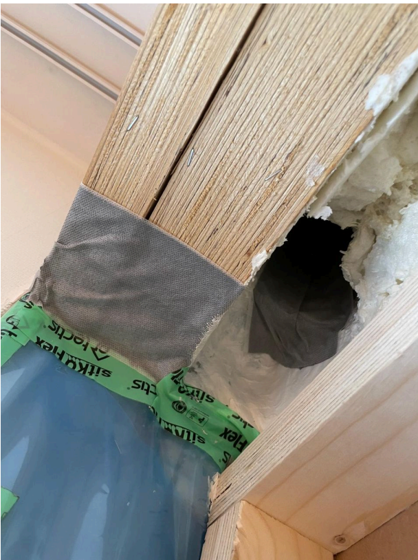
Luokka 211 Höyrösulun liitos vanhaan runkoon seinän yläosassa
