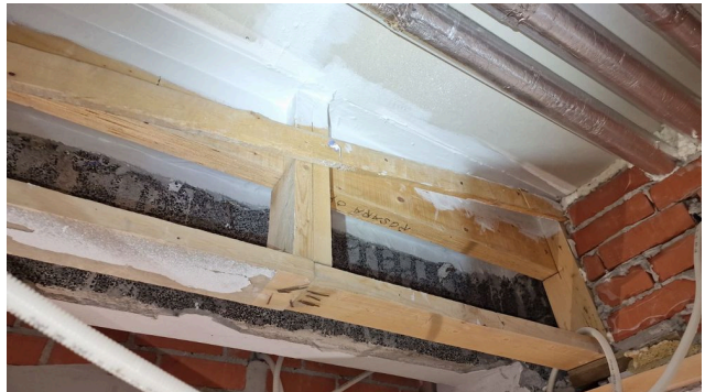
Inva-wc tiivistykset tehty
