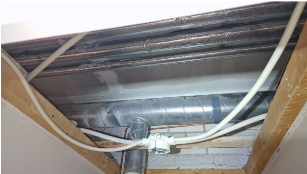
WC, katon saumat tiivistetty
