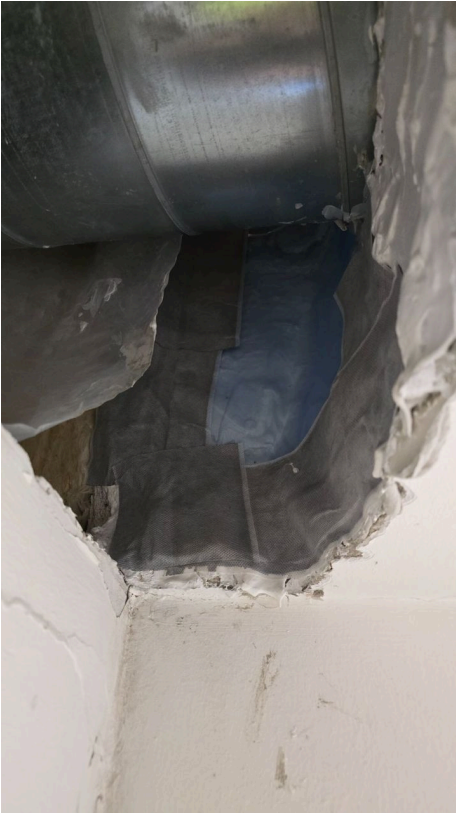
Wc höyrösulun liittämä korjattu vanhaan ulkoseinään
