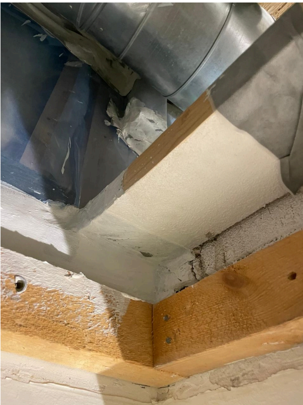
Wc:n ulkoseinällä höyrösulku tiivistetty
