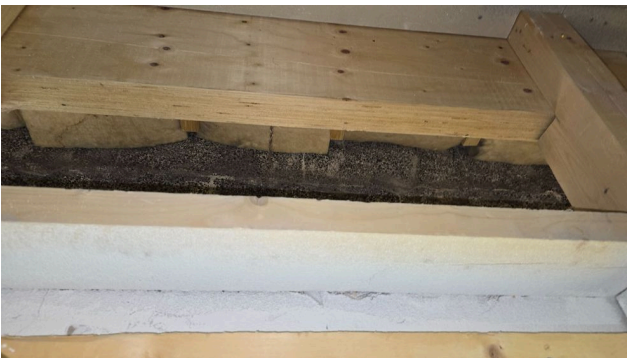
Inva wc kattoon laudat ja levy,villat koteloidaan
