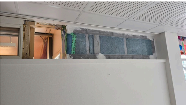
Yläkerran käytävä ikkunan kohta Höyrösulku liitetty kivirakenteeseen
