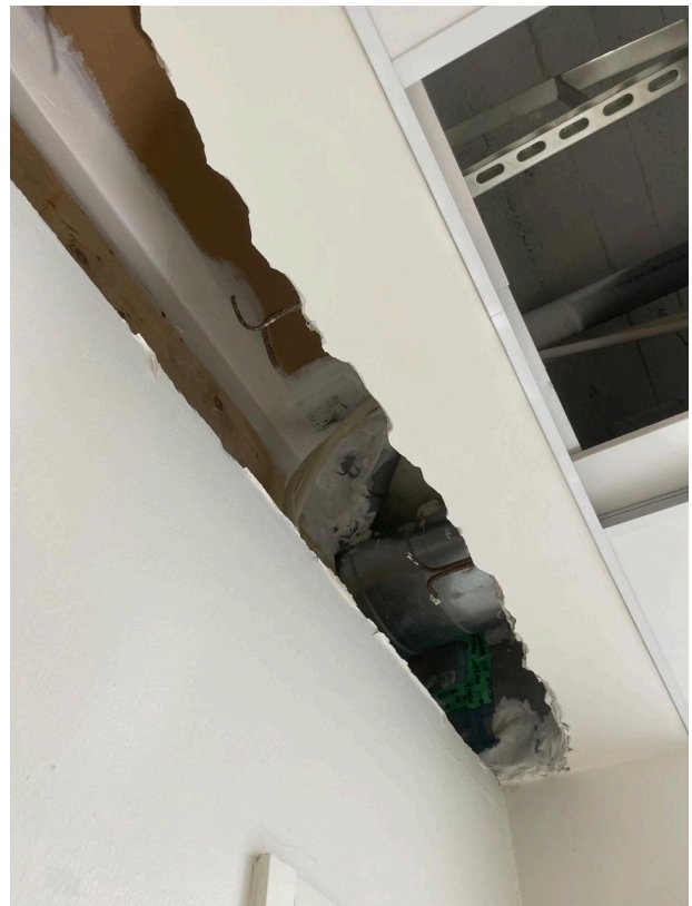
Alakerran käytävä vanhat ulkoseinä harkot poistettu
