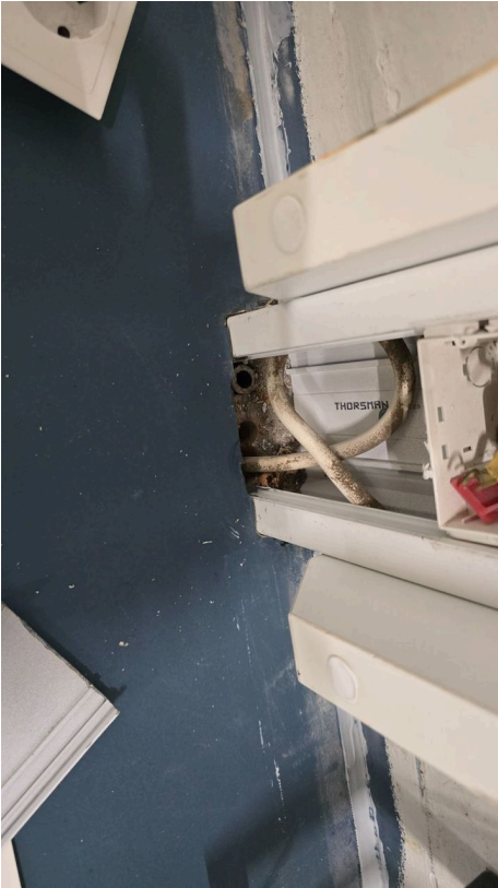
Liikuntasali sähkökourun kohta ennen tiivistystä
