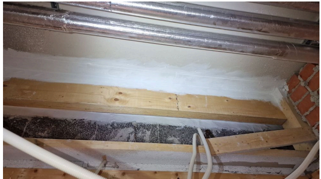
WC palkin liittymät tiivistetty
