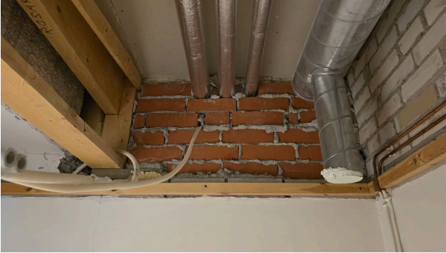
Inva wc villoja seinän päällä, poistetaan
