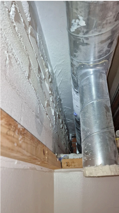
WC tiivistykset tehty katossa
