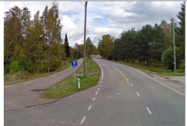
Kuva: Kevyenliikenteen väylä Savelantien varressa keskustaan päin.
