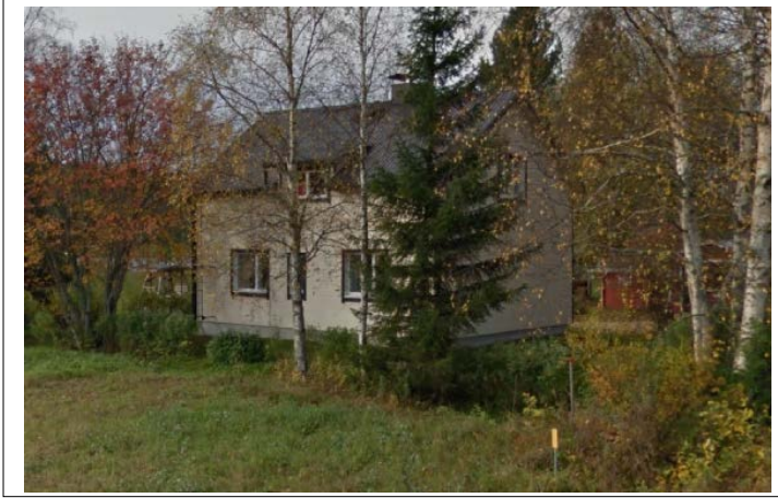
Kuva: Kiviojantie 215. Omakotitalo v. 1960 Talousrakennus v.1954
