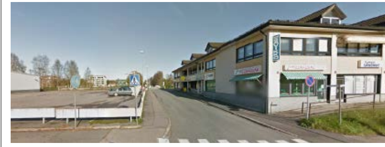
Tontilla 1-1-2 Kiinteistö Oy Savisilta, liike- ja toimistotilaa, rakennusvuosi 2003
