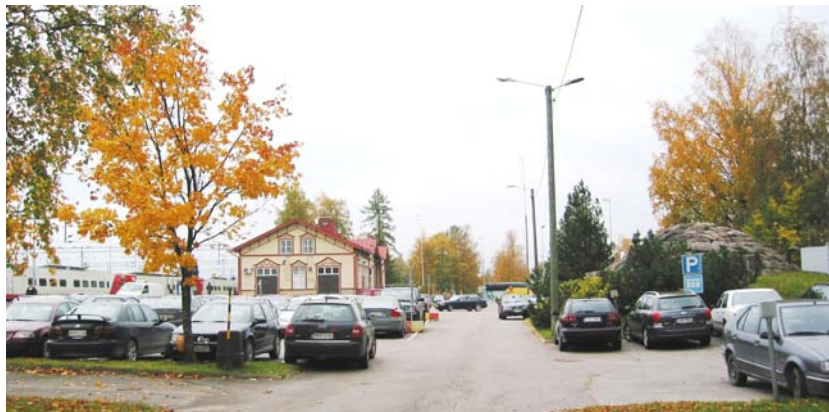
Kuva 27. Asemarakennus pohjoisesta. Pommisuoja kuvan oikeassa reunassa. Asemalle saapuu Pendolino Oulusta.
