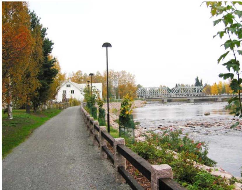
Kuva 21. Meijeri, Savisilta ja rautatiesilta nähtynä Kalajoen pohjoisrannan uudelta kevyenliikenteen väylältä. Meijerirakennus tullaan purkamaan.
