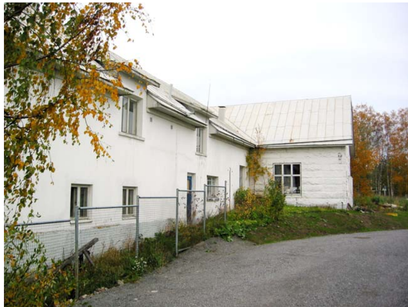
Kuva 11. Meijerin rannanpuoleinen sivu. Rakennus puretaan.
