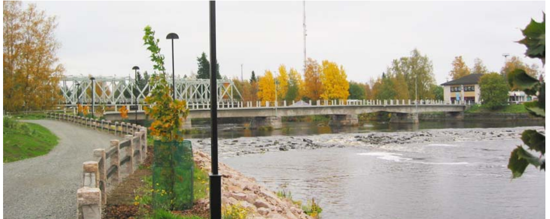
Kuva 12. Savisilta meijerin kohdalta, taustalla rautatiesillan teräsristikot.
