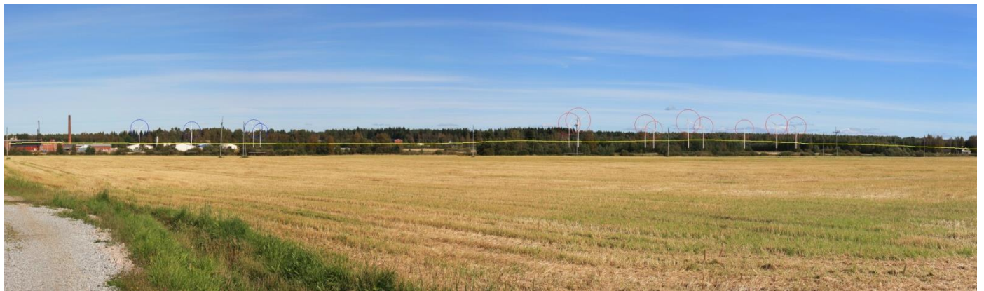
Kuva 84. Valokuviasovite, kuvauspaikka 9 Raudasmäki. Oikealla Urakkanevan voimalat (punainen) ja vasemmalla Hirvinevan voimalat (sininen). Hirvinevan voimaloiden roottoreita näkyy puiden latvojen yläpuolella. Tuomiperän voimalat eivät näy kohteeseen. Pajukosken voimalat eivät näy katselupisteeseen.
