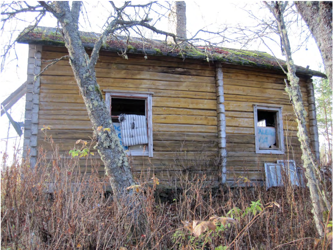
Kuva 17. Julkisivu koilliseen, Kopakkaojalle päin.
