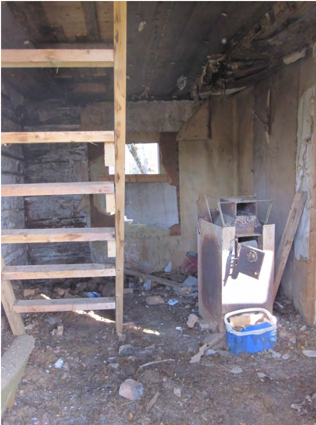
Kuvat 19 ja 20. Vasemmalla näkymä sisäntulo-ovelta kamarin sekasortoon. Oikealla kamarin ulkonurkkaa. Yläpohja on lahonnut ja osittain sortunut katon aukoista vuotaneen veden edesauttamana.
