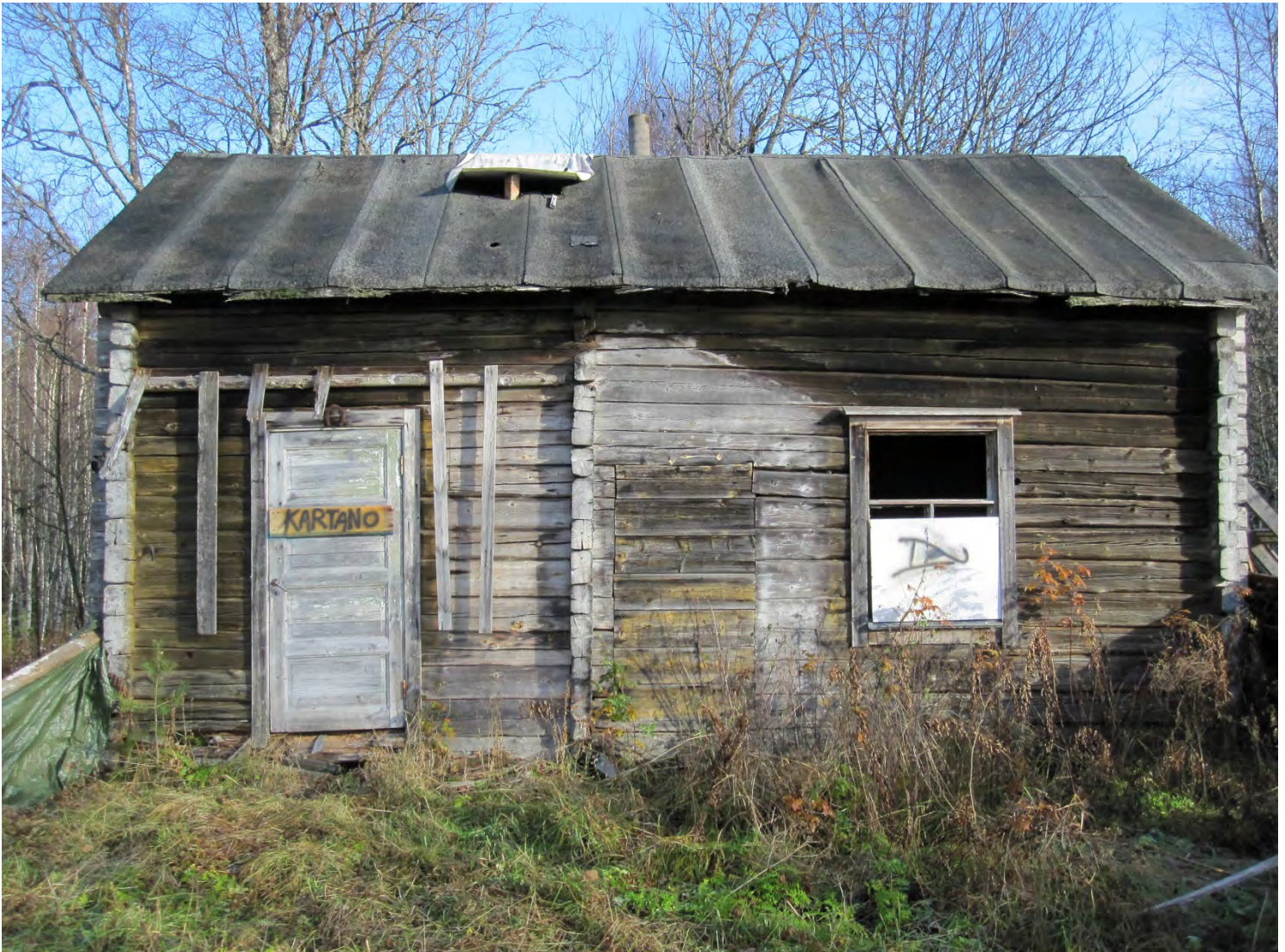
Kuva 14. Rakennuksen julkisivu lounaaseen - sisääntulojulkisivu.
