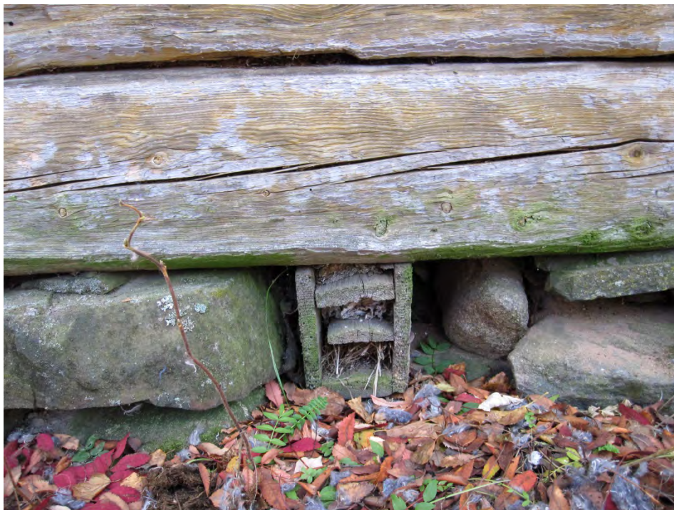
Kuva 13. Kivistä ladottua perustusta sekä puurakenteinen kanava lattian alle.
