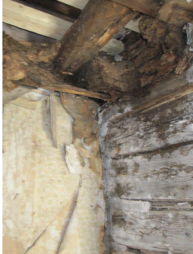
Kuvat 19 ja 20. Vasemmalla näkymä sisäntulo-ovelta kamarin sekasortoon. Oikealla kamarin ulkonurkkaa. Yläpohja on lahonnut ja osittain sortunut katon aukoista vuotaneen veden edesauttamana.
