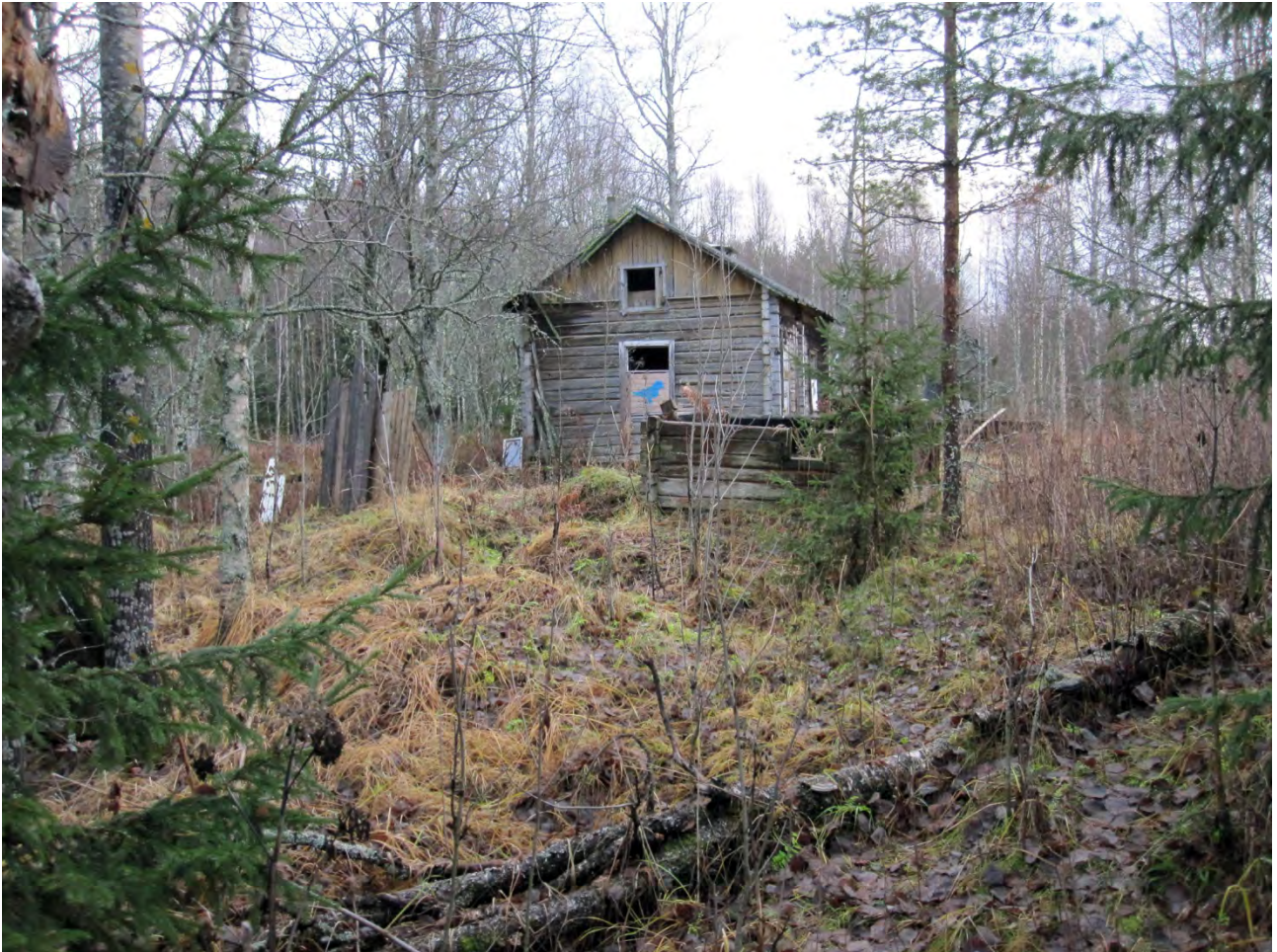
Kuva 2. Hautatalon hirsirakennus pohjoisesta kuvattuna. Edessä osittain maatonut hirsikehä sekä maakuopat.
