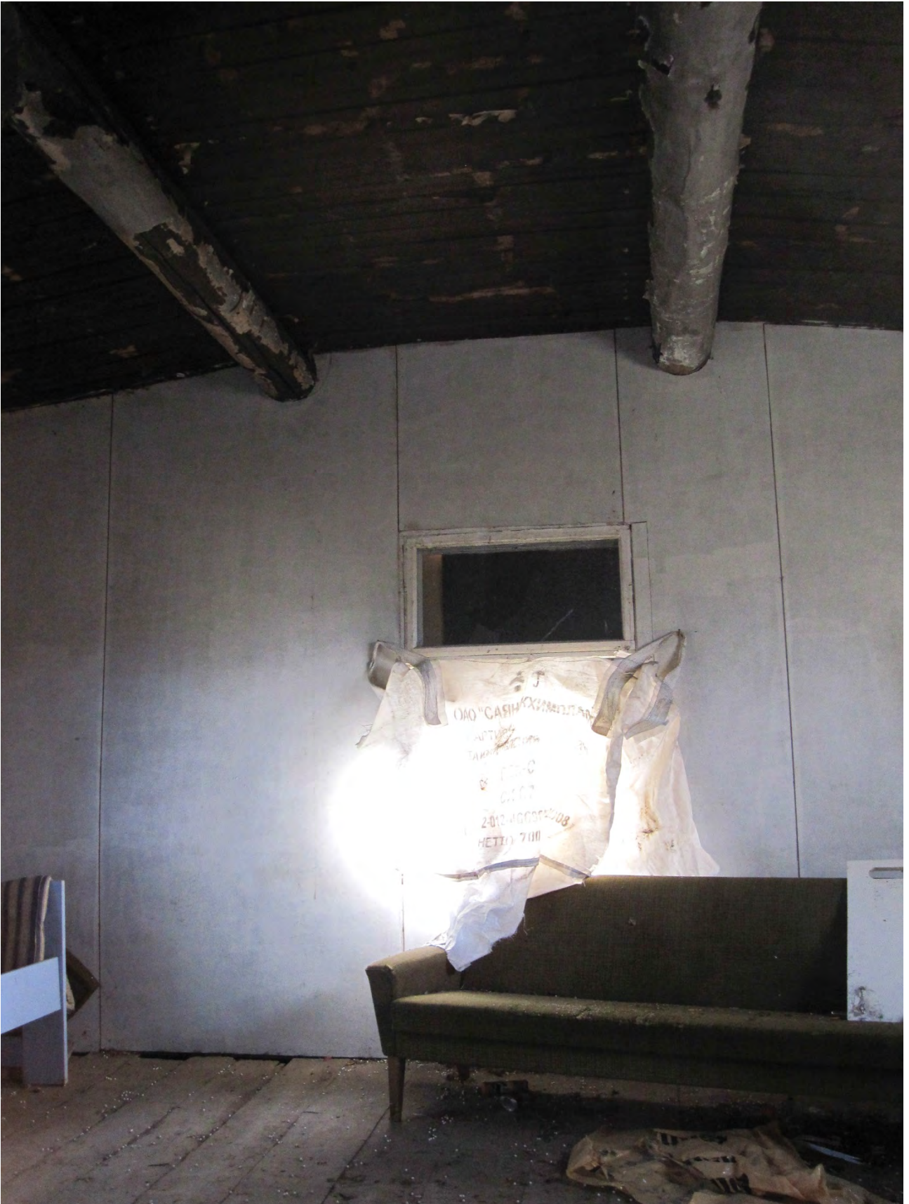
Kuva 23. Näkymä tuvasta. Sisäseinät on kauttaaltaan verhottu kipsilevyllä.
