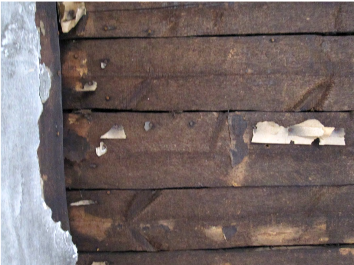
Kuvat 21 ja 22. Ylhäällä kamarin kattolautaa. Alhaalla tapettien alta esiin kuoriutunutta tuvan sahalaudoitettua kattoa. Tuvan kattolaudat ja niitä kannattelevat kattohirret näyttävät nokeentuneilta.
