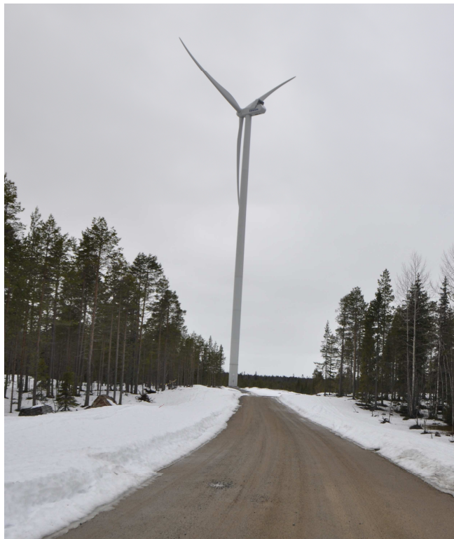
Kuva 15. Tuulivoimaloiden huolto- ja rakennustiestöä rakennetusta tuulivoimapuistosta Iin Olhavasta.
