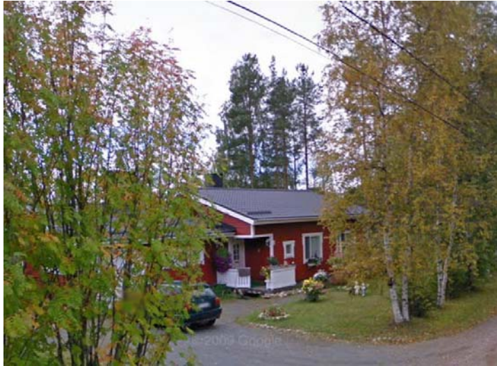
Kuva 6: Tiemestarintie 3, kt 977-406-5-335, rakennettu vuonna 1964
