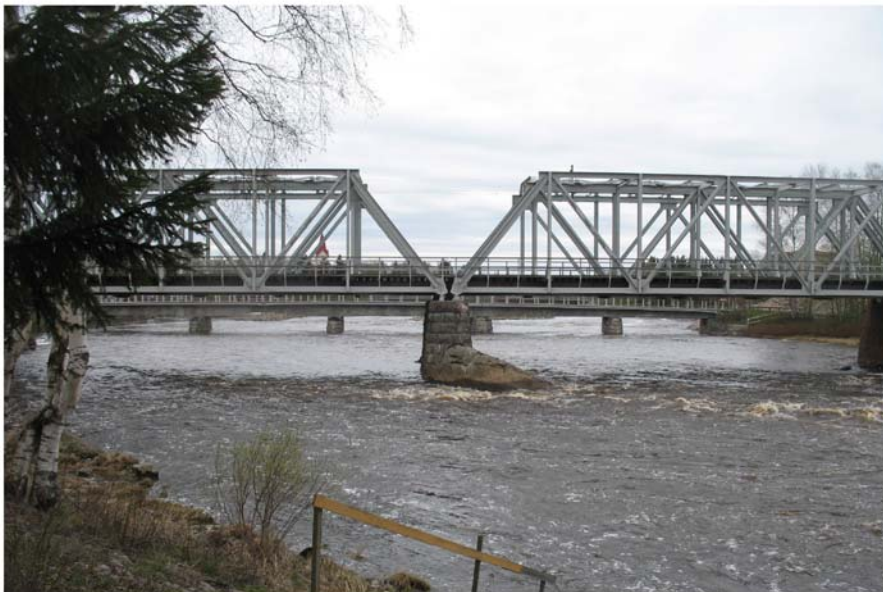
Kalajoen ylittävä ratasilta Salmiperän ja Ylivieskan tärinäriskialueiden välissä.
