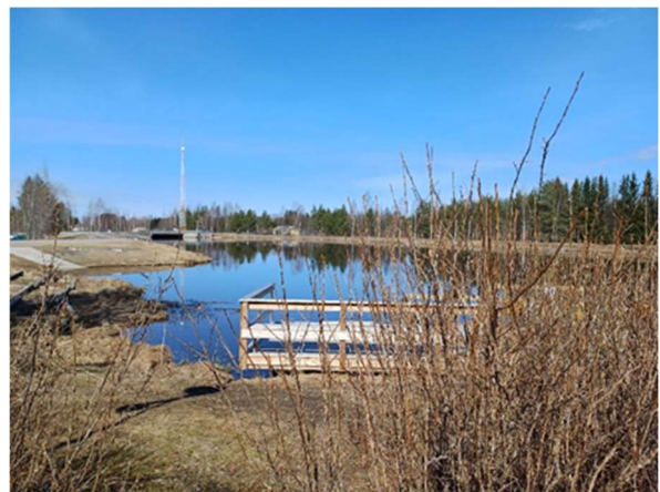
Kuva 7. Hamarin voimalapato sijaitsee rannan välittömässä läheisyydessä
