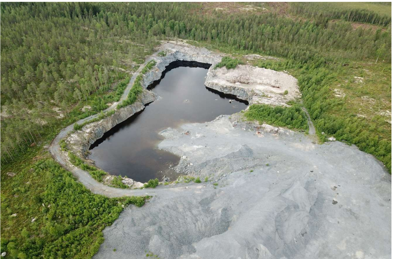
Kuva 2. Louhos hankealueen luoteispäässä. Dronekuva, korkeus 110 m.
