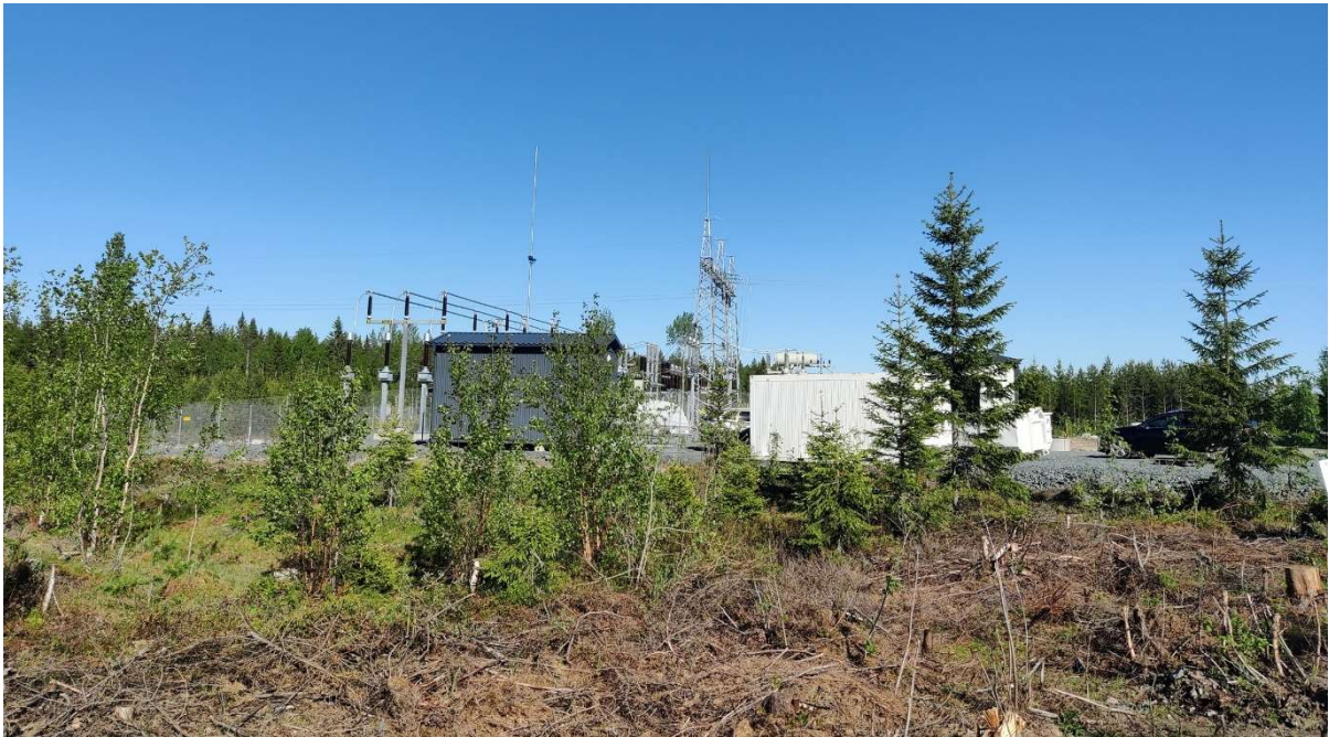
Kuva 25. Rieskannevan sähköasema reitin SVE2 päätepisteessä.
