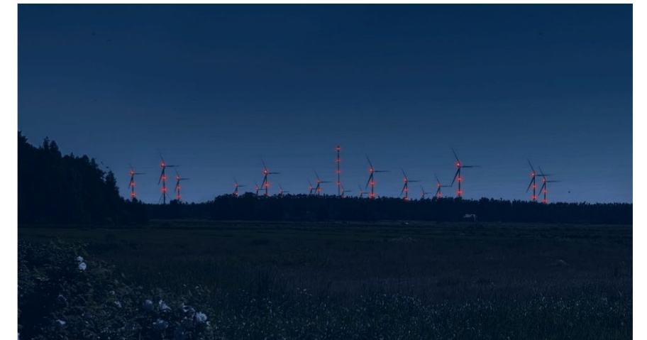
Kuva: esimerkki kuvakäsittelystä yöversiosta. Lentoturvalatkoja on korostettu kuvankäsittelyssä.
