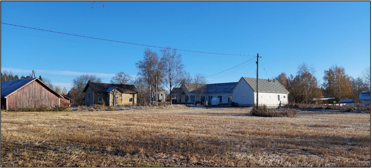
Kuva 9. Pientaloja pihapiireineen alueen eteläosassa. Vasemmalla oleva Heimon tilan asuinrakennus on sittemmin purettu.
