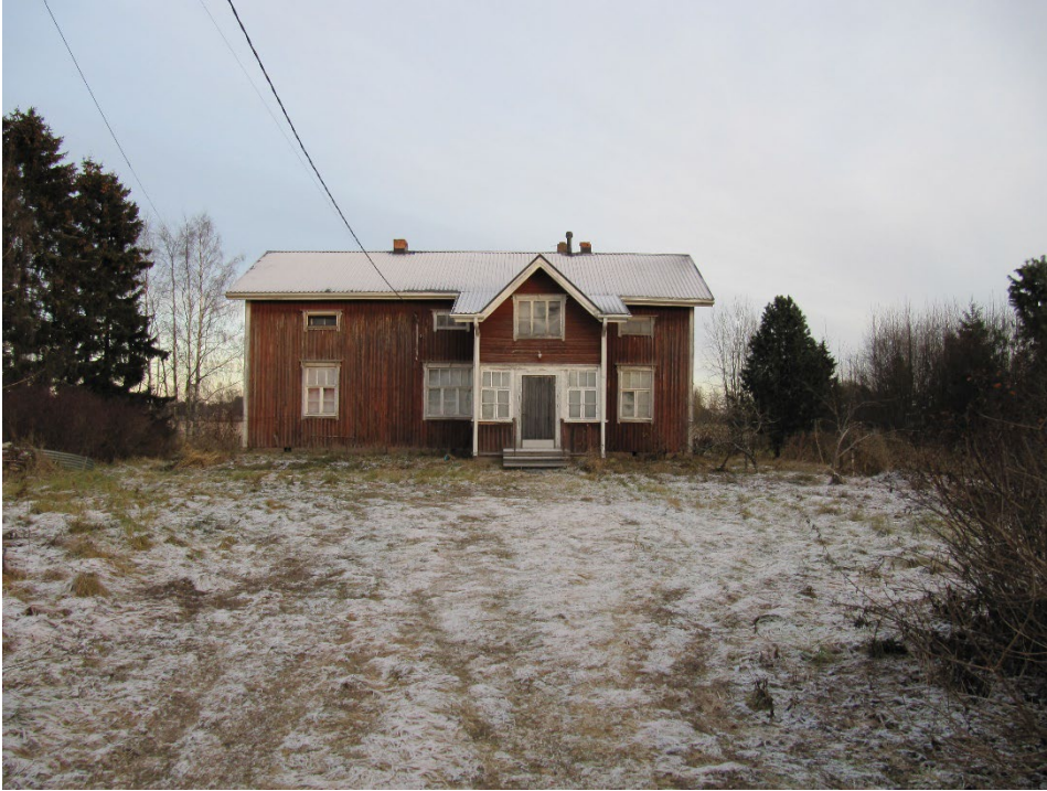
Kuva 18. Kiinteistö 977-406-0012-0102: asuinrakennus (asumaton), v. 1920.
