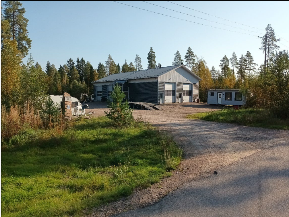
Kuva 4. Suunnittelualueelle vuonna 2013 rakentunut varastorakennus Laattatiellä (kiinteistö: 977-003-0113-0001).
